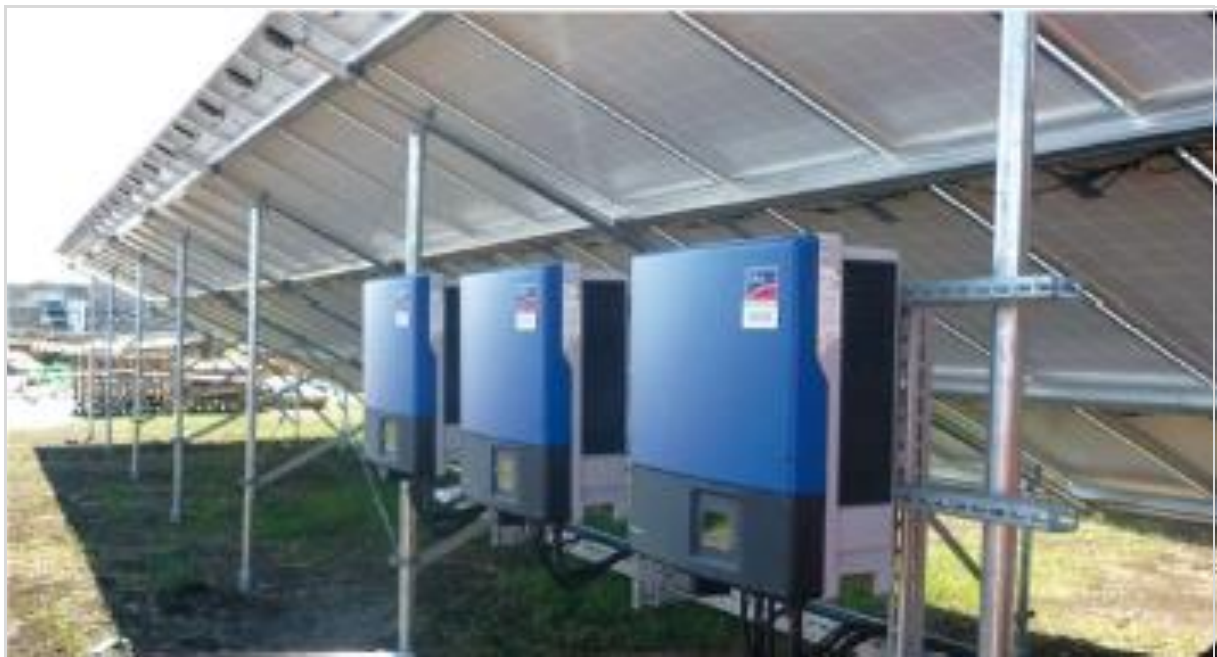
Слика бр. 18: Приказ конструкције на коју се постављају соларни панели и инвертори
