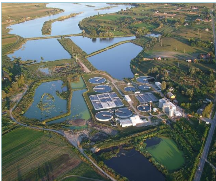
Слика бр. 46: Постојење за пречишћавање отпадних вода са првим сектором језера ( https://vodovodsu.rs/14-preciscavanje-otpadnih-voda )
