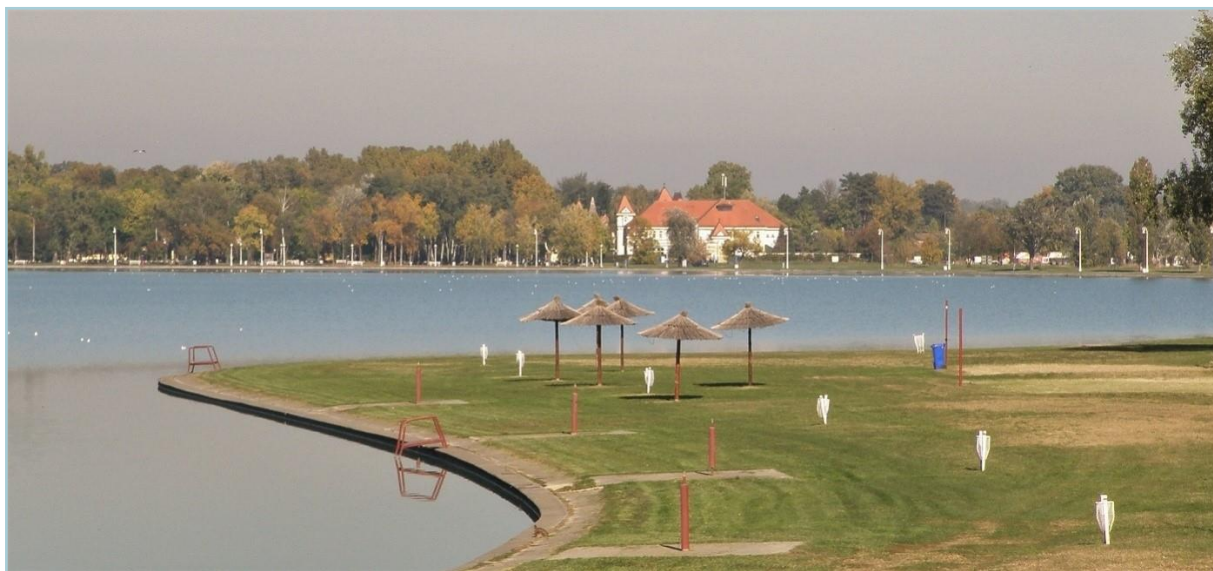
Слика бр. 55: Вертикална обалоутврда од Пешчане плаже до Мушког штранда онемогућује мочварним животињама излазак из воде
