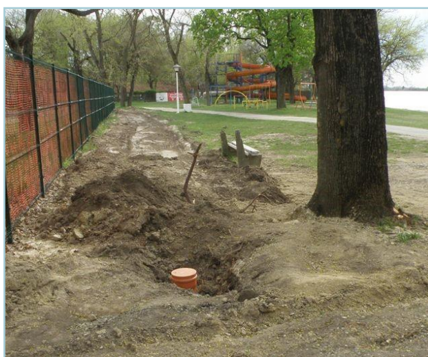
Слика бр. б2: Постављање подземног вода у непосредној близини старог стабла код Мушког штранда
